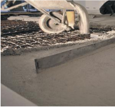
EINBRINGEN, GLÄTTEN, SCHLEIFEN, VERSIEGELN: DIE VERSIEGELUNG MIT WACHS IST DIE NATÜRLICHSTE OBERFLÄCHENGESTALTUNG, AUCH ACRYL IST MÖGLICH
