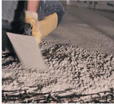
EINBRINGEN, GLÄTTEN, SCHLEIFEN, VERSIEGELN: DIE VERSIEGELUNG MIT WACHS IST DIE NATÜRLICHSTE OBERFLÄCHENGESTALTUNG, AUCH ACRYL IST MÖGLICH
